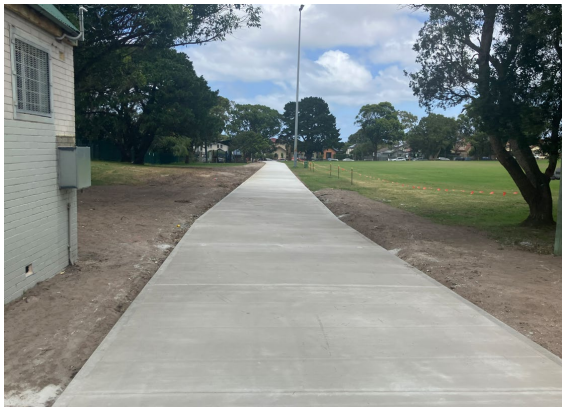
Concrete pour – facing south
